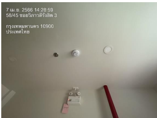
รูปที่ 22 เครื่องตรวจจับควัน (Smoke Detector)
