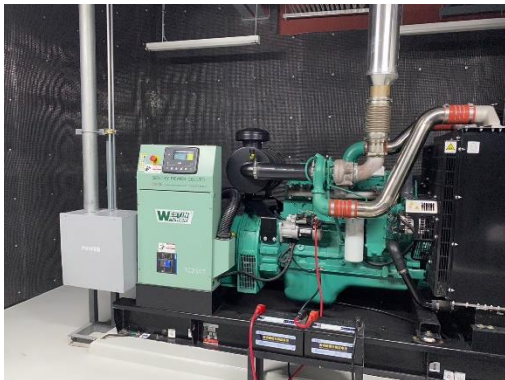
รูปที่ 20 เครื่องกำเนิดไฟฟ้าสำรอง (Generator)
