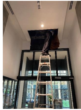
รูปที่ 51 ล้างทำความสะอาดเครื่องปรับอากาศ ส่วนกลาง
