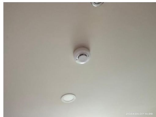
รูปที่ 22 เครื่องตรวจจับควัน (Smoke Detector)
